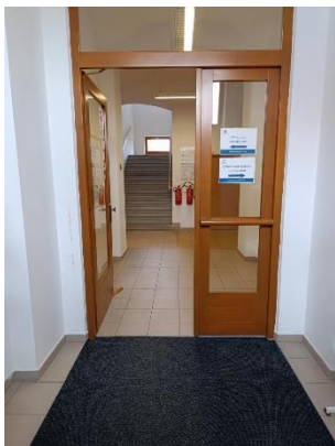
Zádveří za hlavním vstupem
