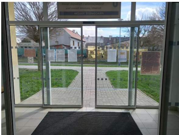
Vstup – automatické dveře
