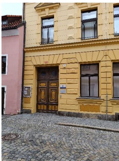
Hlavní vstup do budovy
