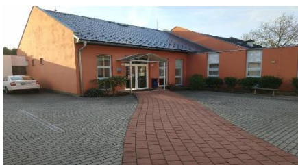
Vchod B, nájezdová plošina z nádvoří
