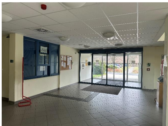
Vstup – automatické dveře a vodící linie k podatelně
