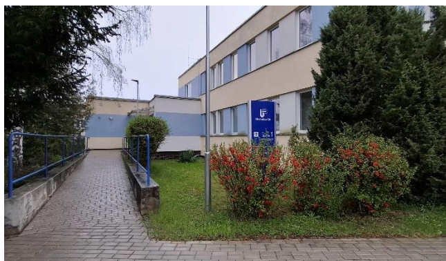
Vstup do budovy č.1
