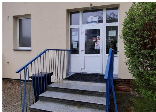
Vstup do budovy č. 2
