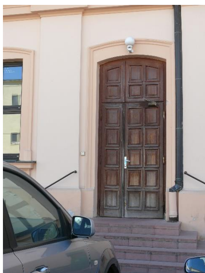
Boční vchod, pouze nouzový východ
