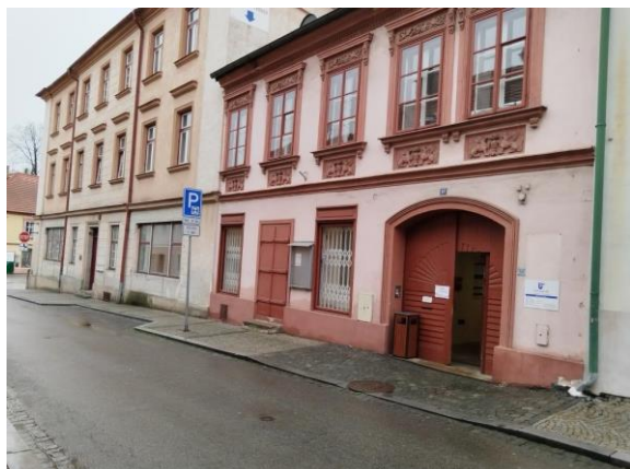
Hlavní vstup do budovy
