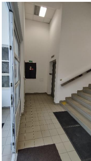
Prostor před výtahem
