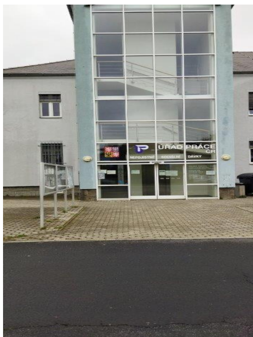
Hlavní vstup do budovy
