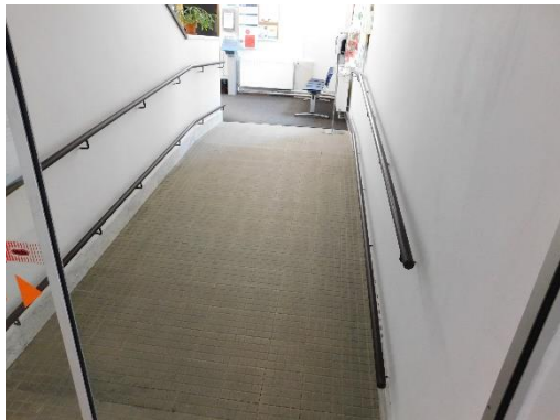
Vjezdová rampa do budovy
