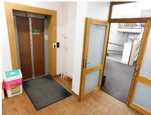
Přístup ze vstupní haly k výtahu
