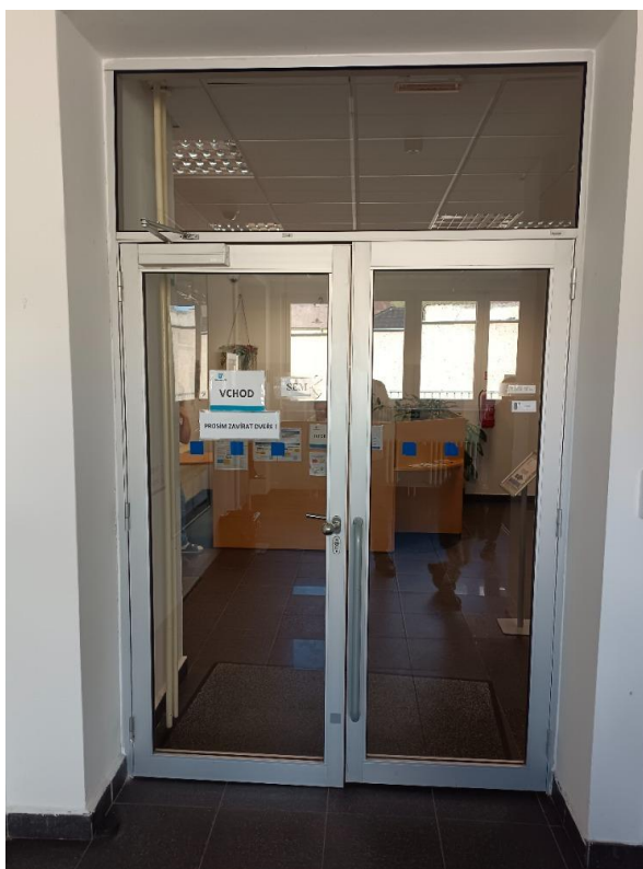
Vstup ze zádveří do vstupní haly
