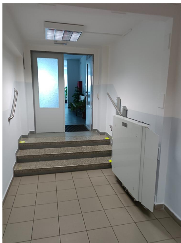
Schody do přístavby s plošinou
