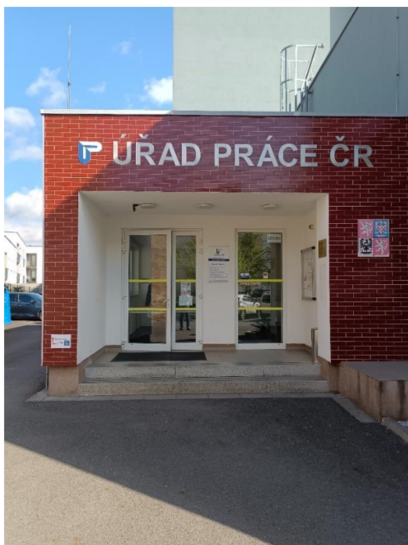
Hlavní vstup do budovy
